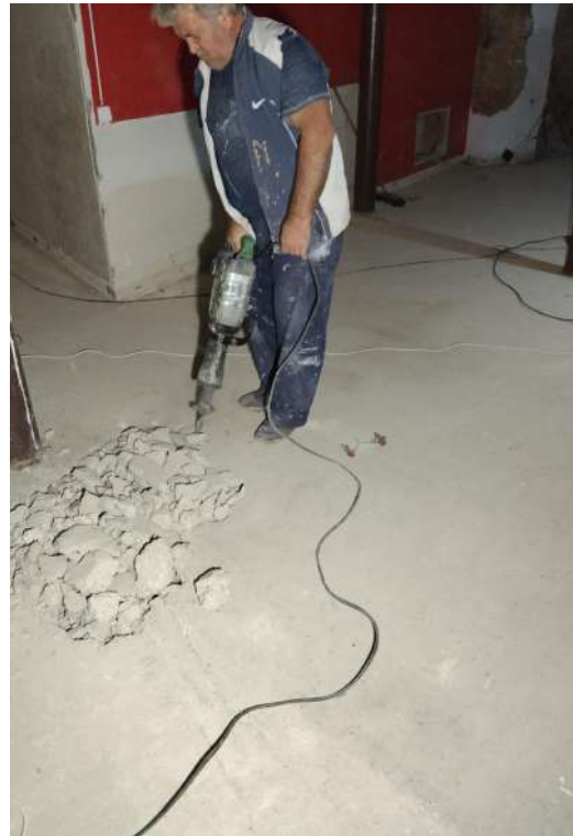
13. Vista del procés d'obertura de la cala 2.
