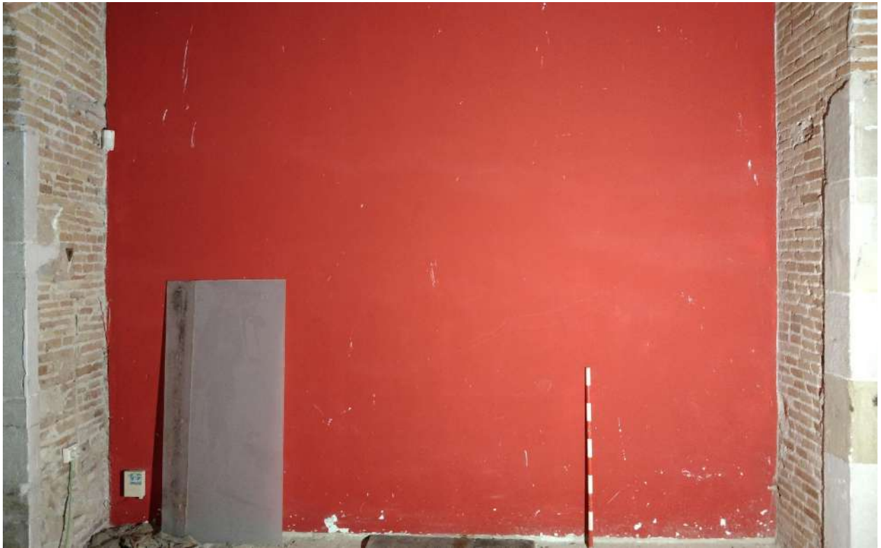
23. Vista del tram de paret abans d'obrir la cala parietal 2.
