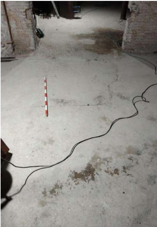
12. Vista final de la cala 1.
