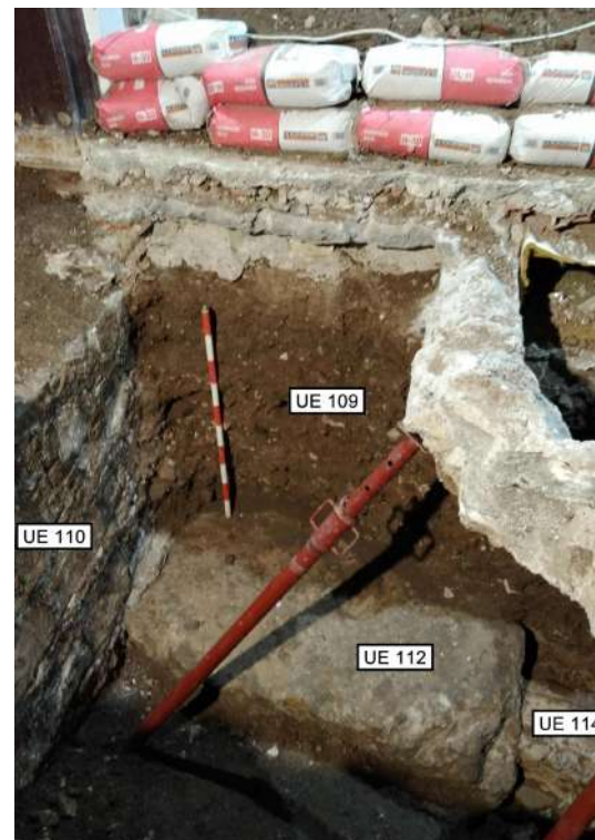
7. Vista de la fonamentació UE 110 muntant-se sobre l'estructura UE 112.
