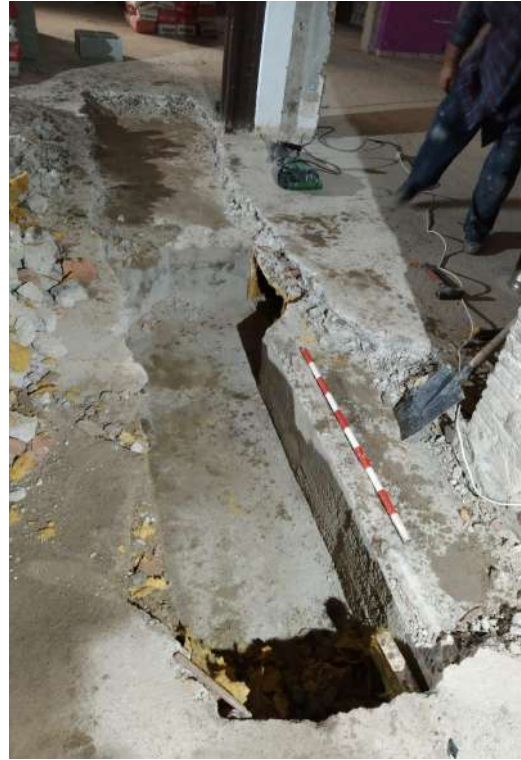
2. Vista en primer pla de canalització de formigó UE 102 amb el paviment de pedres UE 105 al fons.
