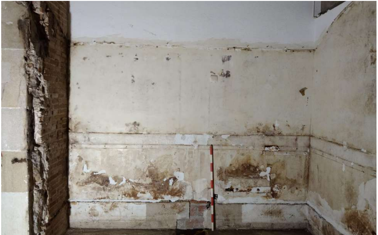
21. Vista del tram de paret abans d'obrir la cala parietal 1.
