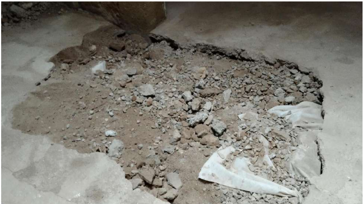
20. Vista final de la cala 3.
